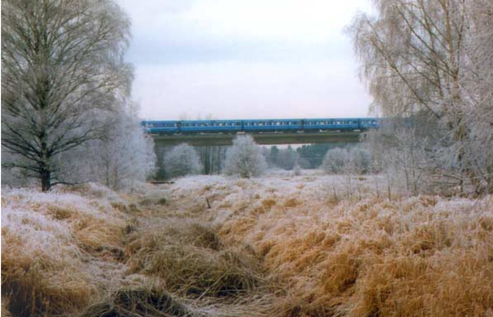
Figur 22. Järvakilen vid Kymlinge med tunnelbanebron. Foto: Ulf Ranhagen.
