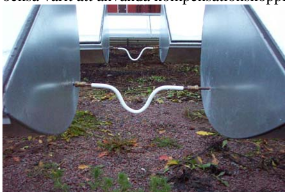
Figur 4, sammankoppling av modulerna med prisolrör.
