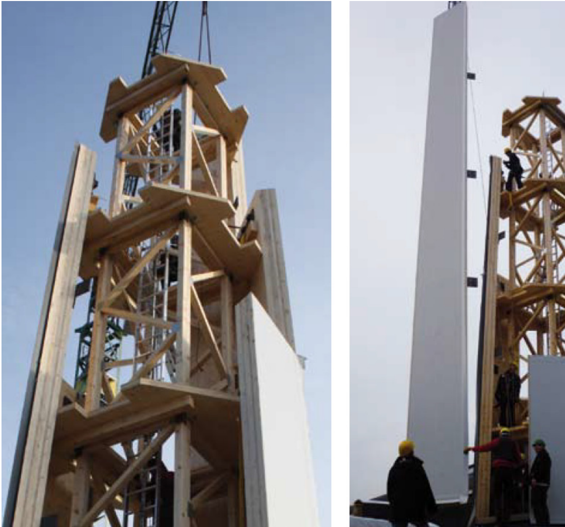
Figur 1 Prototyp av översta 25 m för ett trätorn under montage, [3].
