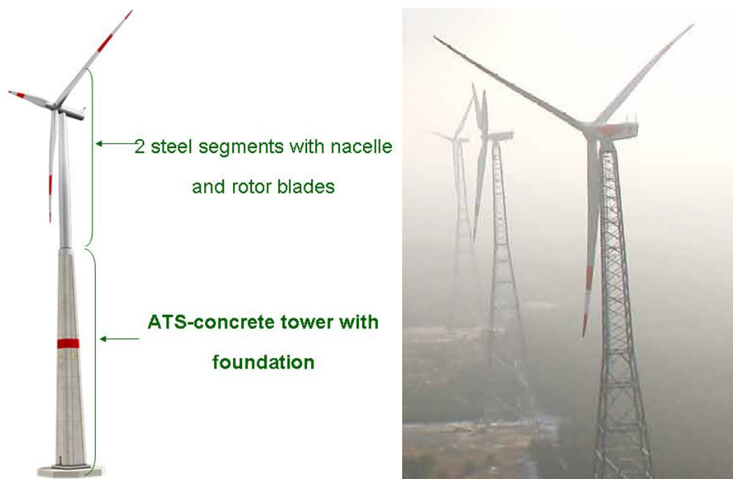
Figur 6 Hybridtorn från Advanced Tower Systems [26] och fackverkstorn med Fuhrländer 2.5 MW turbin från [23] (bilden är beskuren).
