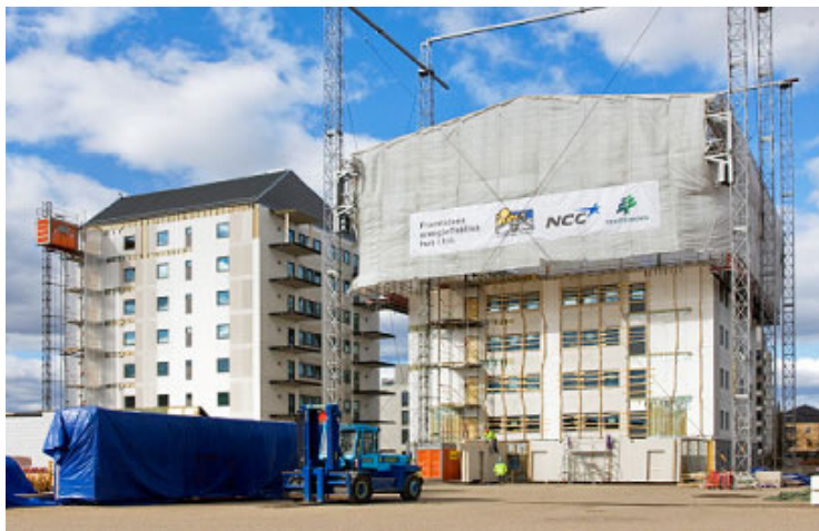
Figur 7 Byggnation av höga träbuss med byggsystem från Martinssons, bild från [30].
