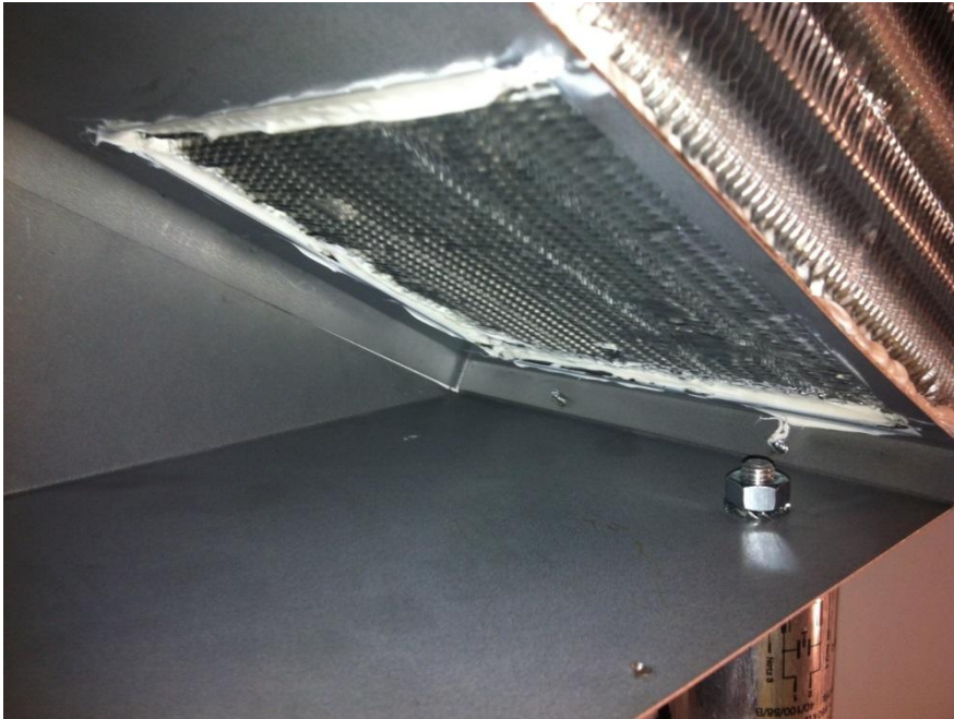
Bild 2. Appliceringen av silikon mellan ram och värmväxlare.
